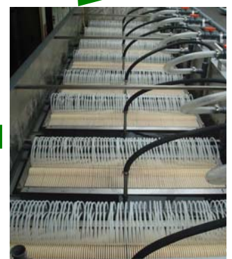
MBR tank + MBR modules
